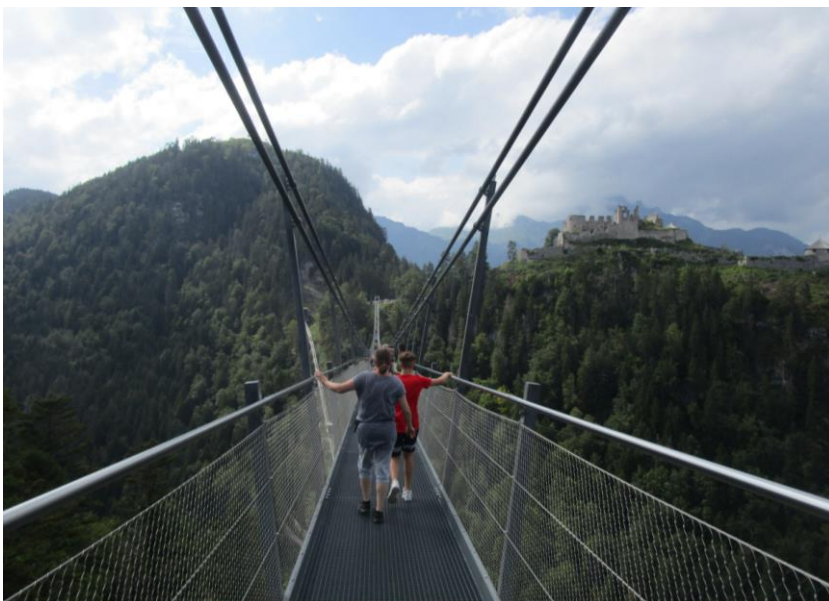
Hängebrücke highline 179 zwischen Fort Claudia und Burgruine Ehrenberg. Es handelt sich mit 406 m Spannweite um die längste Fußgänger-Hängebrücke der Welt im Tibet-Style. Sie erstreckt sich in einer Höhe von 113 m.
